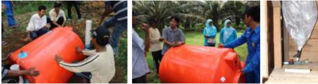
Gambar 2. Pelatihan Pembuatan Digester Biogas dan Gas Holder
